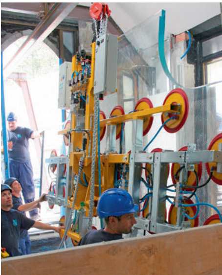
Das Glas wird hydraulisch von der vertikalen Position in die Horizontale gebracht.
