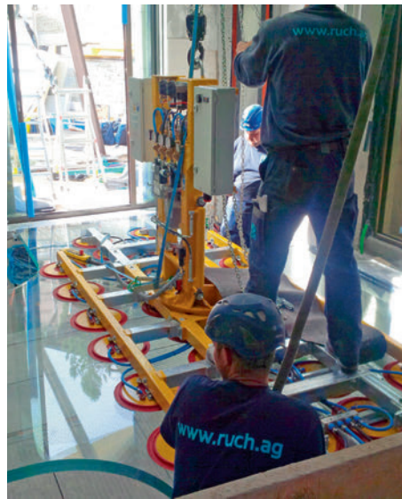
Das Glas, gehalten von der Vakumanlage, wird langsam abgesenkt.
