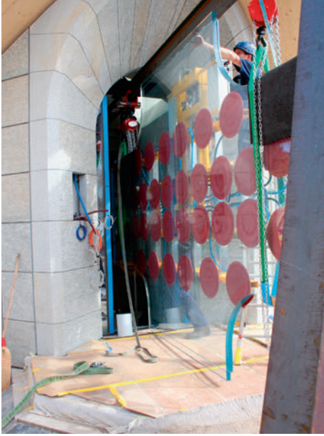
Das Glas wird horizontal durch die engen Türöffnungen in den Raum transportiert.
